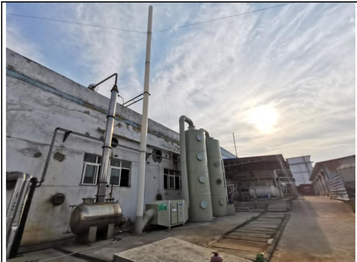
一合成车间有机废气处理装置和排气筒
